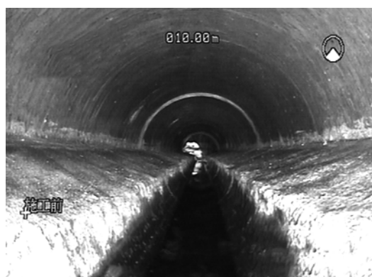
写真－7 施工前の管内状況（管口より10m）
