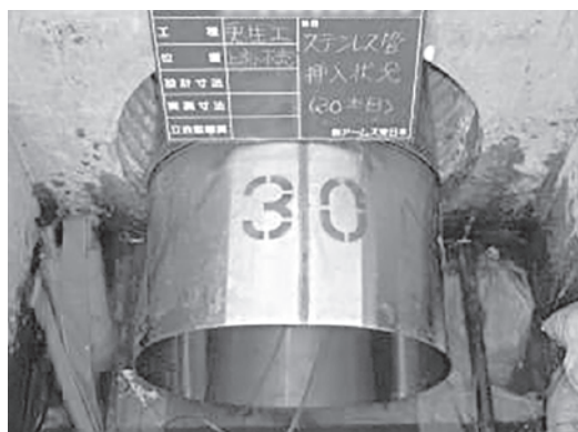
写真-3 更生管の挿入状況
