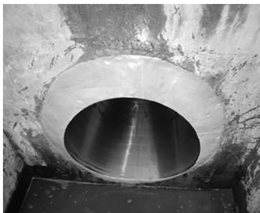
写真-4 管口仕上げ工
