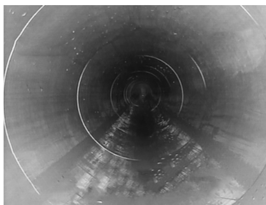
写真-6 管更生工施工後の管内の状況 (SSL-V工法)
