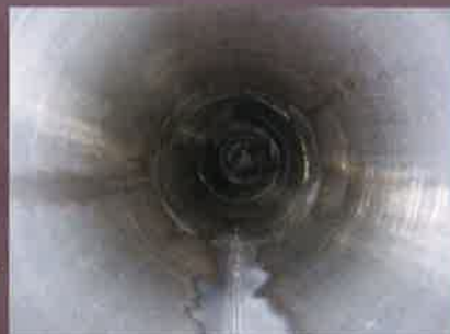
施工後の管内
